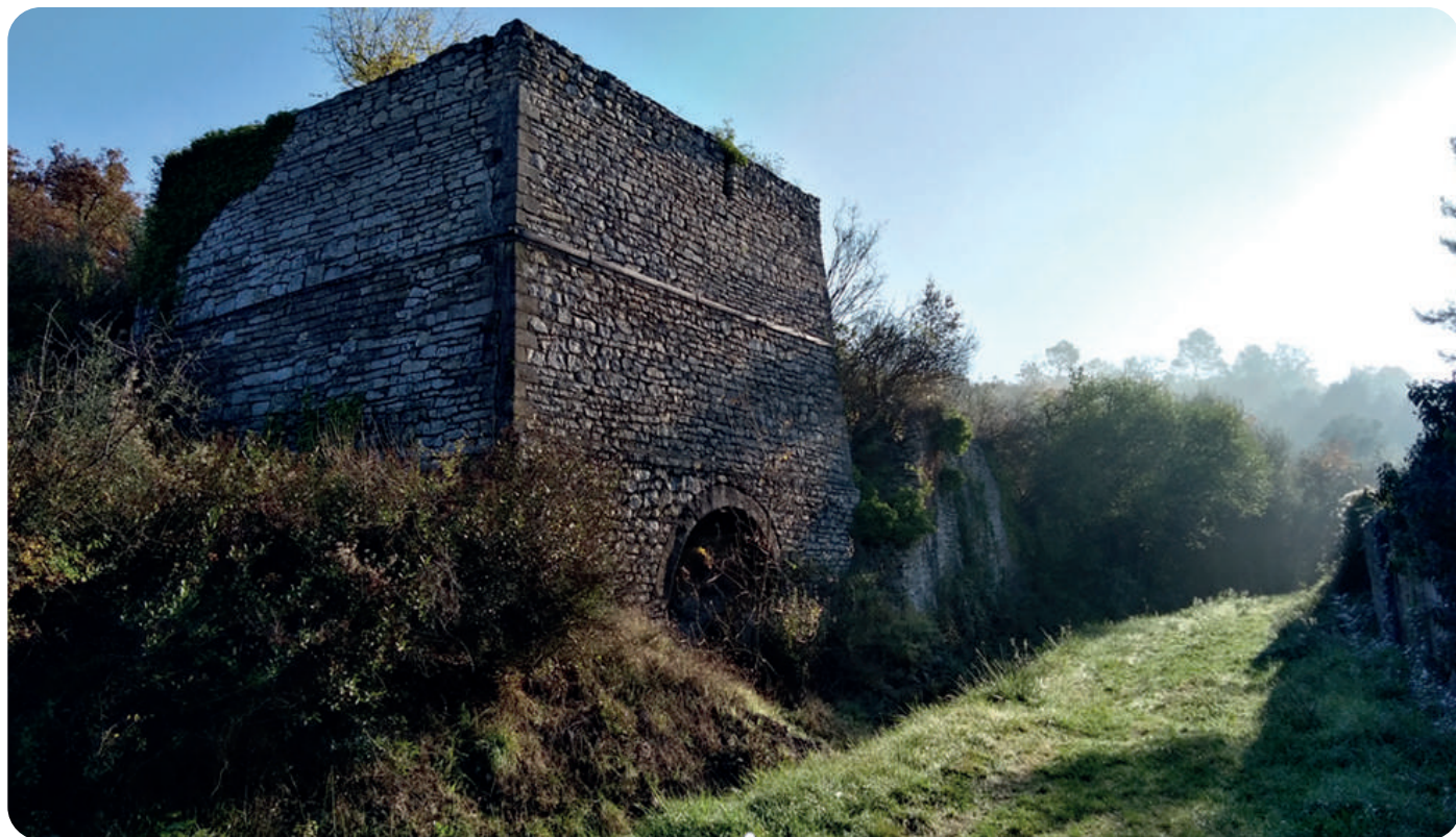
Four à chaud situé au chemin de Courneuve
